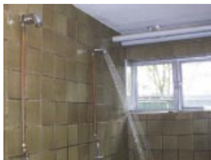
Abb. 12: Duschen mit Durchfluss 30 l/min
