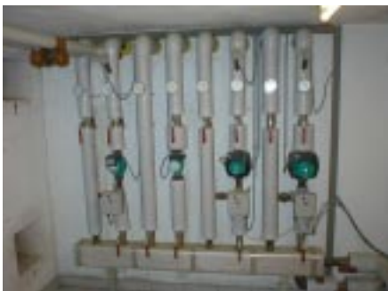
Abb. 2.1: Gedämmte Rohrleitungen
