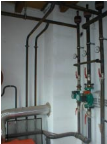
Abb. 2: Ungedämmte Rohrleitungen
