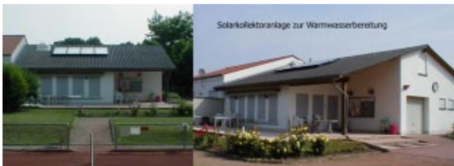
Abb. 24: Solarkollektoranlage TSG 1846 Mainz-Bretzenheim
