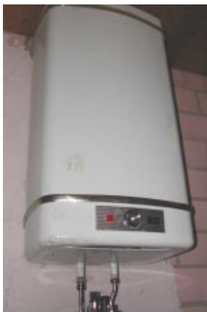
Abb. 8: Veralteter Elektroboiler
